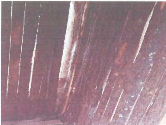
Foto 3: CAMBIO DE MADERA POR BLOCK
