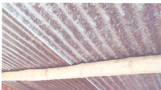
Foto 3: MEJORAMIENTO DE MODULO DE COCINA, CUBIERTA DE LAMINA TROQUELADA CALIBRE 26
