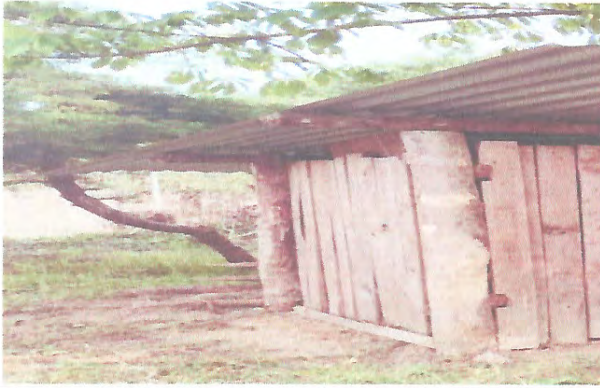
Foto 1: MEJORAMIENTO DE MODULO DE LAVAMANOS
