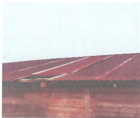
Foto 1: MEJORAMIENTO DE MODULO DE COCINA
