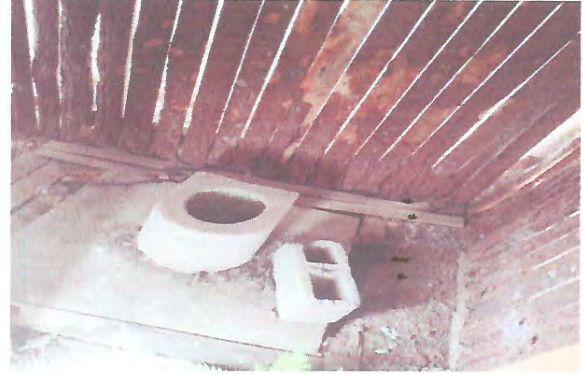
Foto 2: MEJORAMIENTO DE MODULO DE SANITARIOS Y LAVAMANOS
