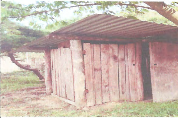
Foto 1: MEJORAMIENTO DE MODULO DE SANITARIOS Y LAVAMANOS
